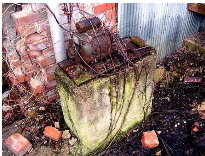
Figura 24 - Incêndio Classe "A"
